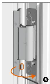
Untere Verstellspindel bei allen Bändern demontieren.
